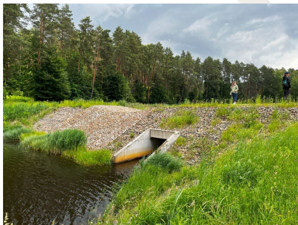
Kuva 10. Metsäympäristön pienvesistö, jota voisi kutsua uudislammeksi. Se toimii samalla sadevesivalunnan hidastajana ja patona suuremmille vesimäärille, jotka tulevat ylärinteiden suunnasta. Pato tasaa erityisesti rankkasateiden aiheuttamaan vesimäärää ja lampi itsessään hidastaa veden pintavalumista pois metsästä.
