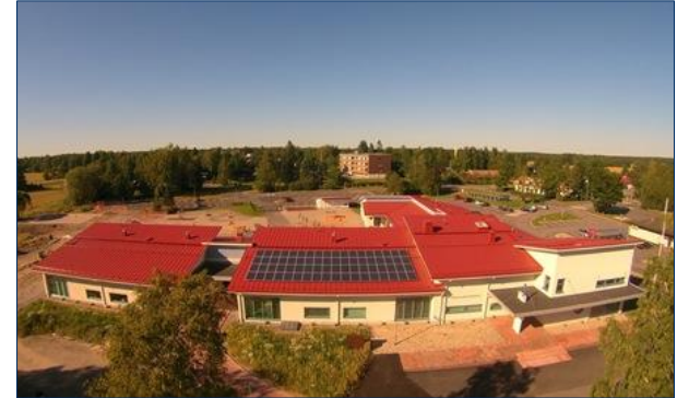
Pikkulaurin päiväkotii, n. 20 kW. Mynämäki.
