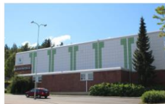
Taajuusmuuttajat ilmanvaihtokoneisiin Akaan monitoimihallissa
