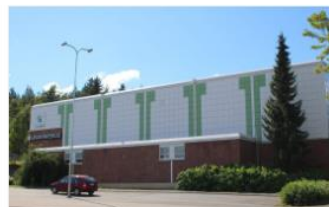
Taajuusmuuttajat ilmanvaihtokoneisiin Akaan monitoimihallissa
