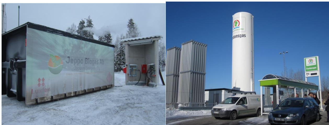
Kuva 3. Biometaanin kuljetuskontti Jepuulla (vasemmalla) ja biometaanin tankkausasema sekä LNG/LBG back-up Eskilstunassa (oikealla).
