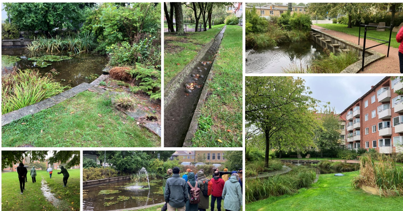
Kuva 4. Kosteikkopuutarha kaupungin vuokratyöyhtiön korttelipihaalla Augustenborgin asuinalueella. Sadevesi tulvi säännöllisesti 1950-luvulla rakennettujen talojen kellareihin ja tilanteeseen etsittiin ratkaisuja 2000-luvun alussa. Päädyttiin avokanaviin ja hulevesien hallintaan kosteikon avulla. Vesikanavien pohjissa oli erikokoisia esteitä, joiden tarkoituksena on saada mutkia virtaukseen ja siten happea sekoittumaan veteen. Näin vesi pysyy liikkeessä eikä alahaisemaan. Samoin alkuperäinen kosteikko on muutettu nykyään lammen muotoon, sillä seisovassa vedessä viihtyneet
