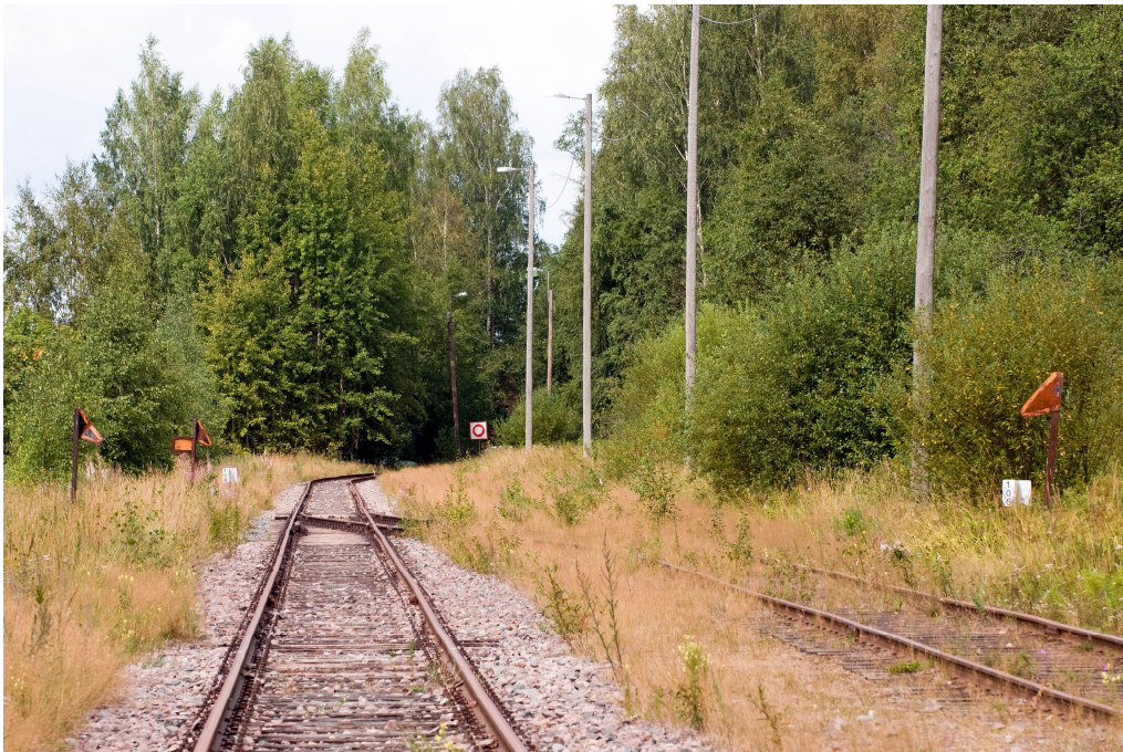
Kuva 12. Otavan sataman raiteistoa. Raide johtaa sahan nykyisin puretulle raiteistolle.
