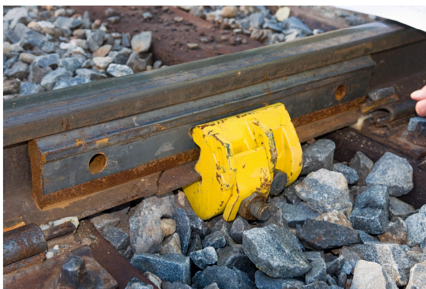
Kuva 18. Väliaikaisesti korjattu kiskonmurtuma Ahonkylässä Seinäjoen ja Koskenkorvan välisellä rataosuudella.
