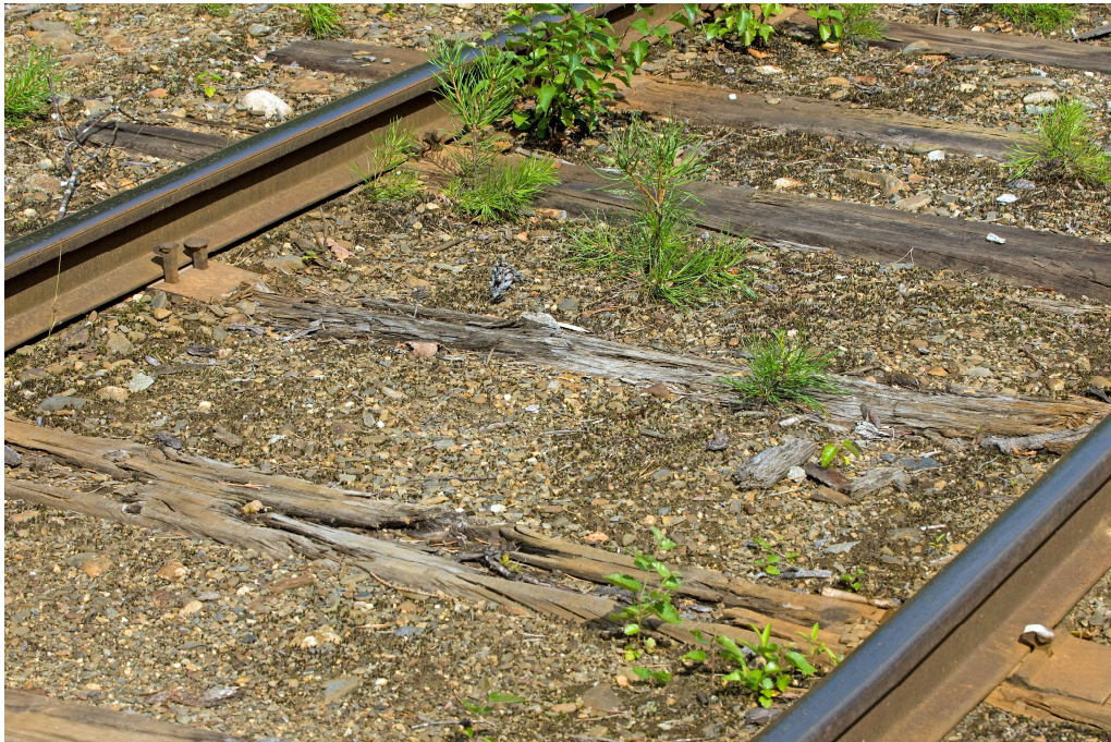
Kuva 20. Pölkkyt Ilo-mantsin radalla on paikoin elinkaarensa lopussa erityisesti Tuupovaaran ja Ilo-mantsin välillä.
