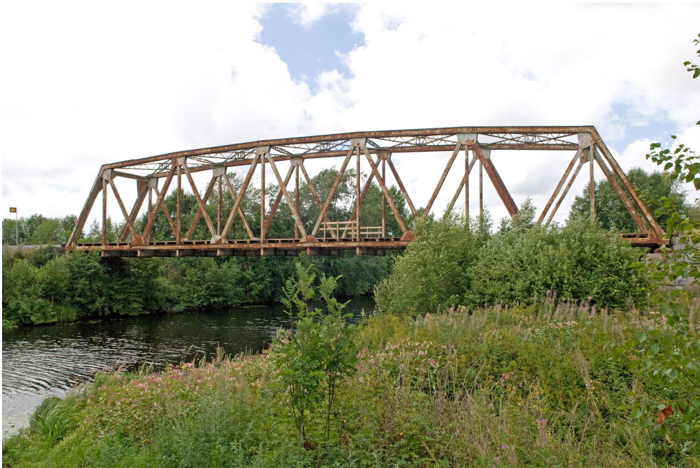
Kuva 19. Närpiönjoen ratasilta vaatii monen muun Seinäjoki-Kaskinen rataosan sillan tavoin jo erityistä huolenpitoa. Sillat ovat pääsääntöisesti yhtä vanhoja kuin vuonna 1913 Kaskisiin valmistunut rata.
