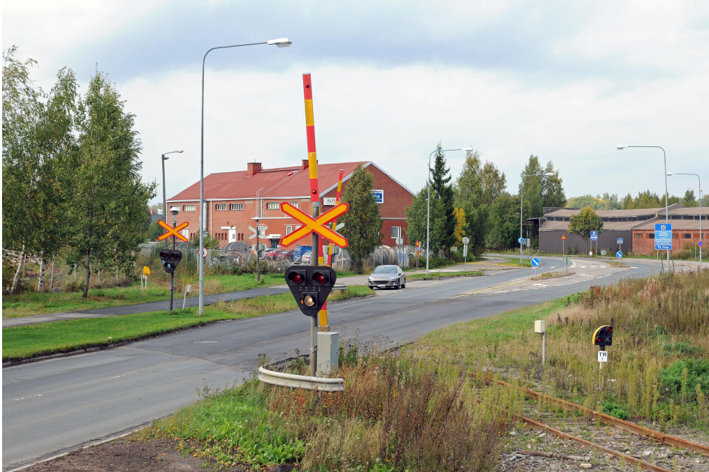
Kuva 6. Radan yli on vedetty asfaltti. Junilla ei enää tasoristeystä ylitetä.
