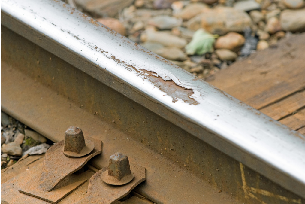
Kuva 21. Ilomantsin radan K30-kiskoissa esiintyy rosoja ja ympärilyöntivikoja runsaasti nousuissa ja kaarrepaikoissa. Kuva Tuupovaaran itäpään lähtökaarteesta.
