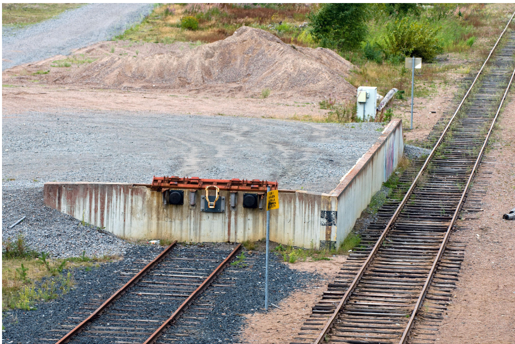
Kuva 15. Päätty- ja sivukuormauksen mahdollistava laituri Niinisalossa.
