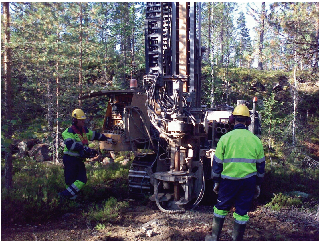
Lopakankankaan maa-ainestutkimukset käynnissä, eo/1 nro 40
